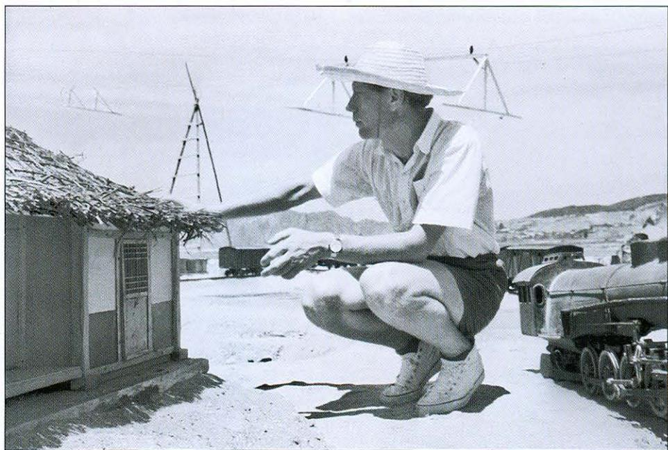
нодорожный подвижной состав. Макет паровоза — наиболее трудоемкая часть этих работ, — именно поэтому его ходовая часть рассчитывается на длительное и многократное использование в съемочном процессе. Сделать другой котел и будку намного проще, — поэтому все шасси и паровозов, и вагонов существуют долго.
