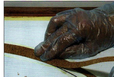
обладает двумя важными преимуществами: наряду с шумопоглощающим эффектом оно имеет очень натуральный цвет земной поверхности. Поскольку далее предстоит балластировка пути, при которой стрелочные переводы, в целях обеспечения надежности работы, покрываться балластом не будут, появятся участки «голой» балластной призмы. В случае с пробкой это будет выглядеть вполне натурально.
